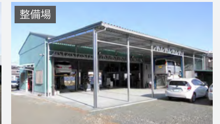
整備場 間口 15.0m 奥行 9.0m 軒高 4.9m 135.0㎡
