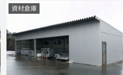
資材倉庫 間口 15.0m 奥行 5.5m 軒高 3.4m 82.5㎡
