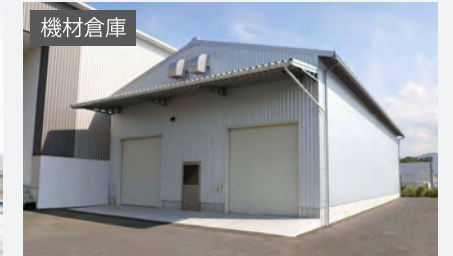
機材倉庫 間口 19.6m 奥行 10.0m 軒高 5.1m 196.0㎡
