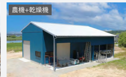
農機+乾燥機 間口 14.4m 奥行 8.0m 軒高 5.3m 115.2㎡
